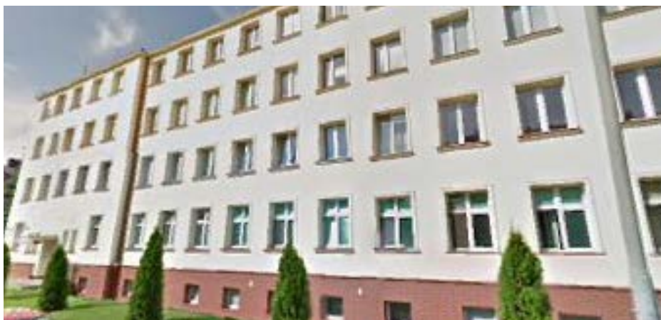
Ryc. 3. Wojewódzka Stacja Pogotowia Ratunkowego – siedziba firmy (stan obecny)
